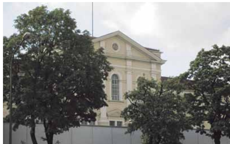
Die Justizvollzugsanstalt München-Stadelheim. Schwer, das einstige Hauptgebäude hinter heutigen »Sicherheitsstrakt«-Mauern noch ins Bild zu bekommen. In diesem wurden in der NS-Zeit weit über 1.000 Todesurteile »vollstreckt«. Ermordet wurden hier neben vielen anderen die Geschwister Scholl. Und auch mehrere Mitglieder des Hartwimmer-Olschewski-Widerstandskreises.
